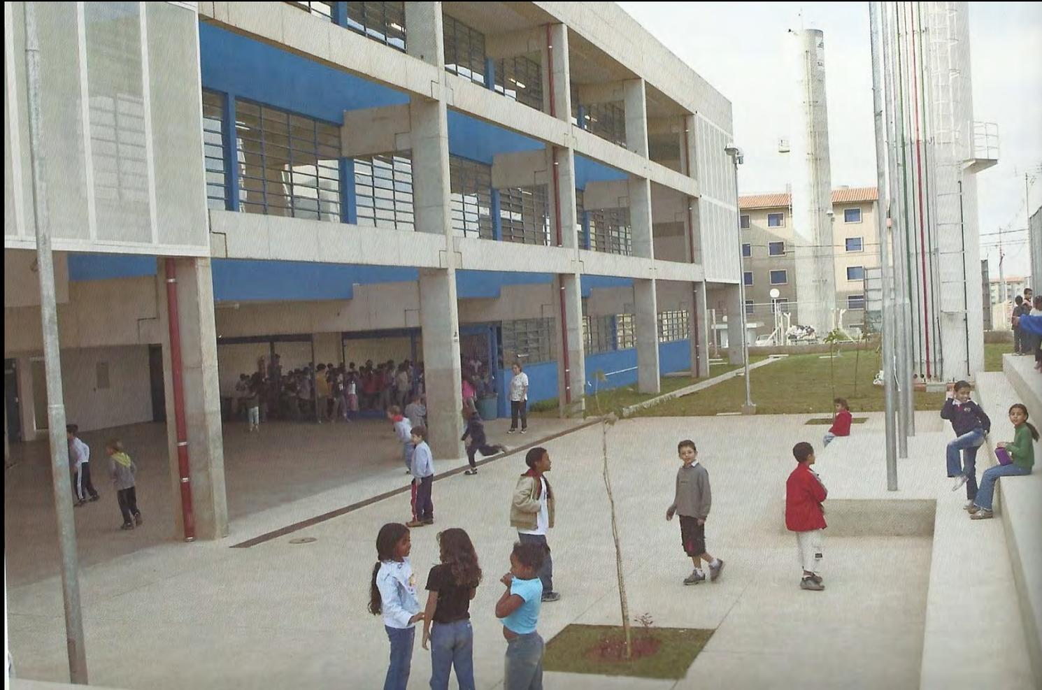
**Viga de borda alinhada pela face externa do pilar**
