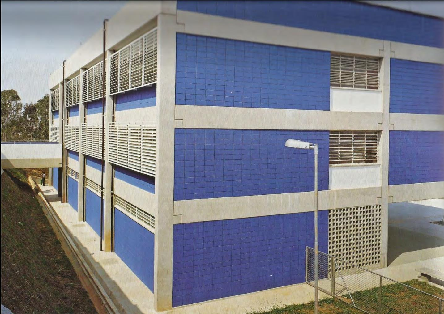
**Viga de borda alinhada pela face interna do pilar**
